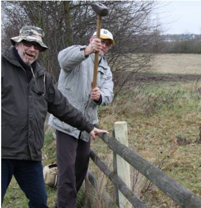
Peter Erlemann vollendet die Aufstellung des Zaunpfostens.
