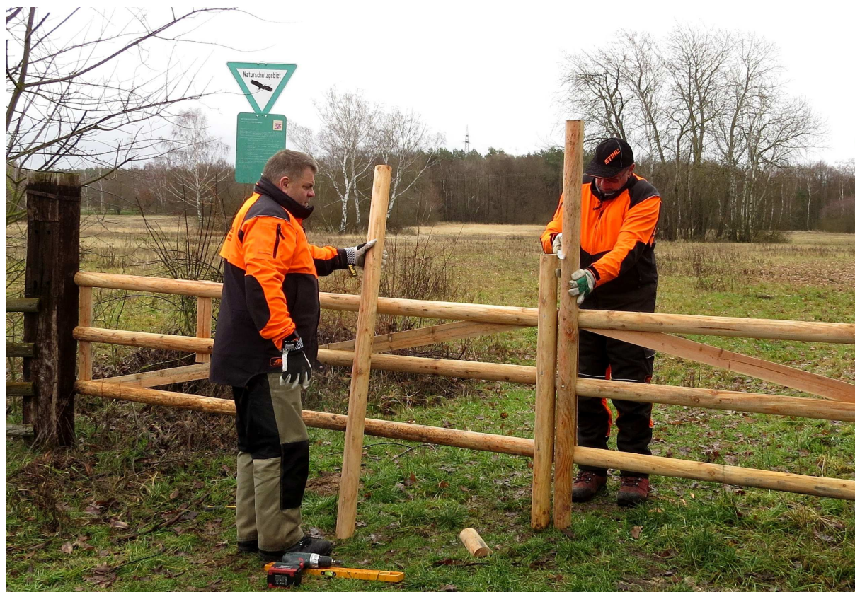
Johann Pfeifenberger und Stefan Horvath bei der Erneuerung der Toranlage.
