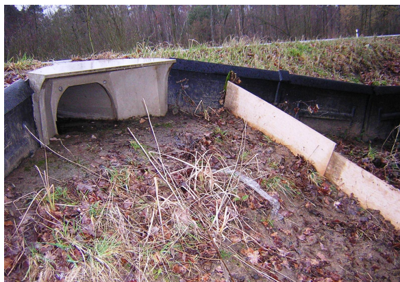
Eine Sperre soll zum Wandern durch den Tunnel zwingen. Foto: 4.3.2009, P. Erlemann
