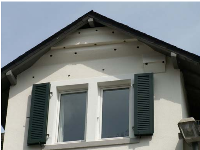
Mauerseglerschutz der ganz besonderen Art. Im Giebel seines Hauses in Kronberg im Taunus hat Erich Kaiser zahlreiche Einflugmöglichkeiten geschaffen, die zu Nistboxen im Dachraum führen.
