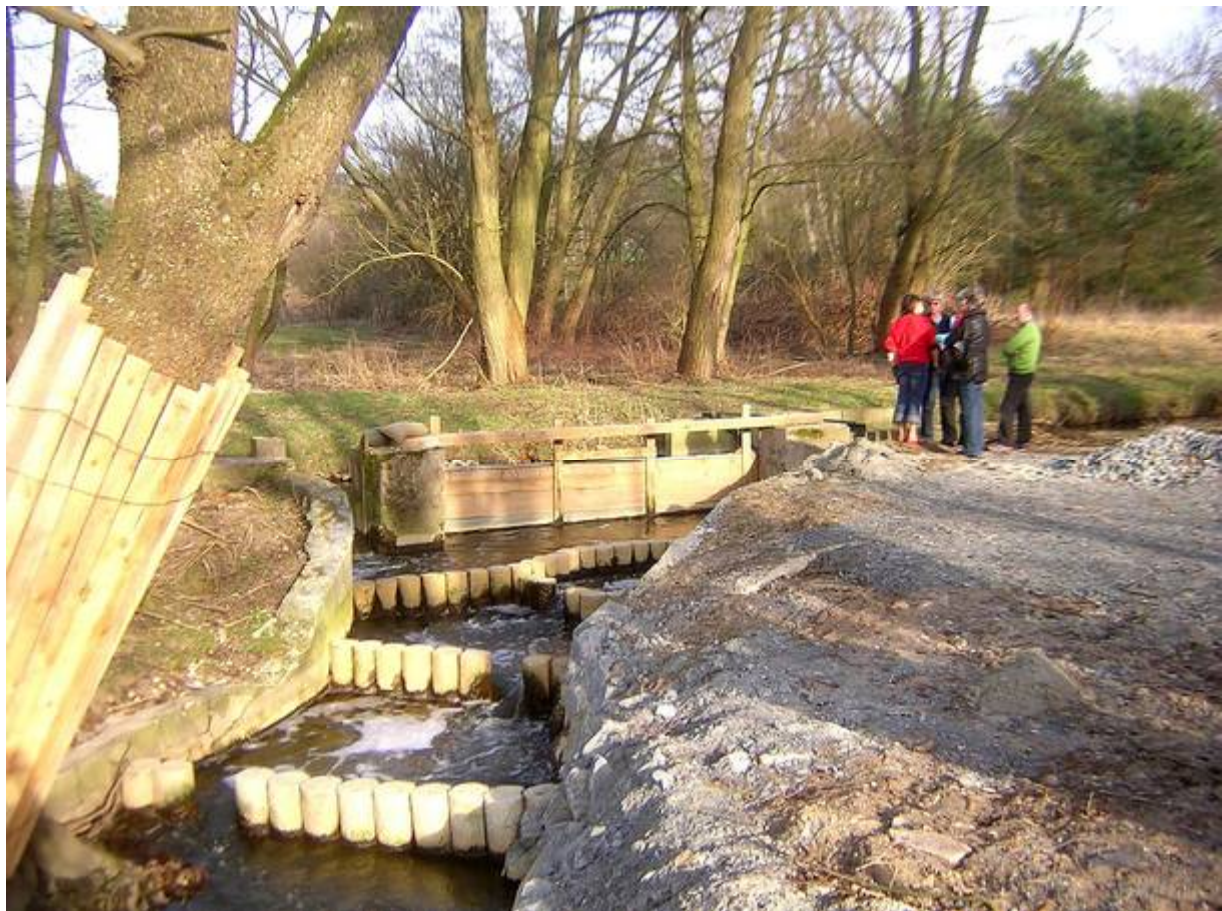
Die Fischtreppe am Abzweig des Brühlgrabens von der Rodau. Foto: P. Erlemann, 19.3.2010
